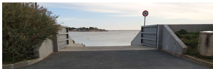
Porte à marée à Angoulins (17) Crédit Photo ASDP
