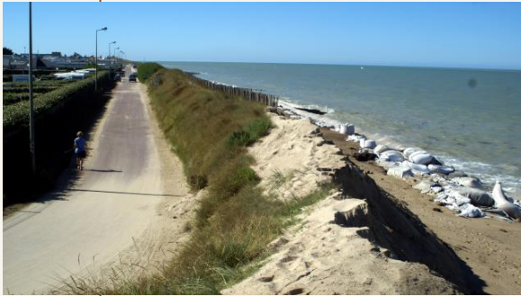
A Gouville sur Mer, l'érosion menace deux campings...
