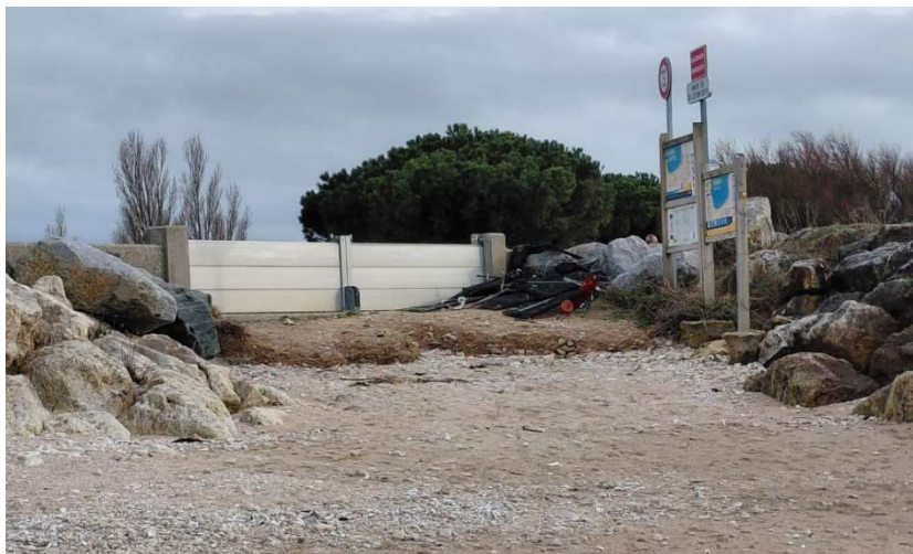
Batardeau entrée plage Aytré (17)
