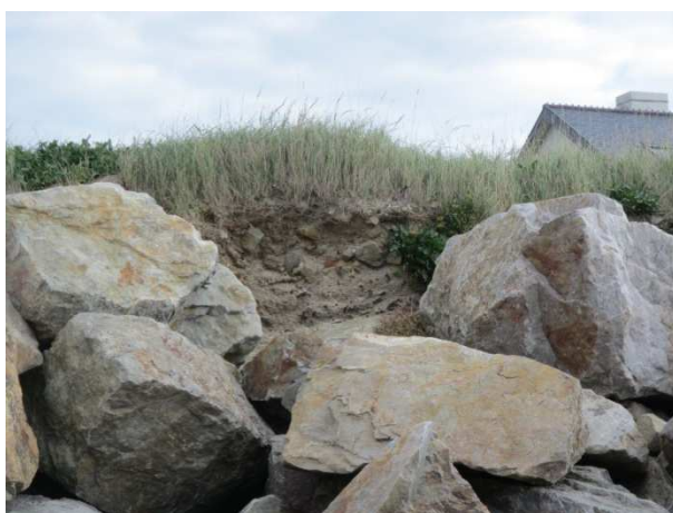
Petite anse d'érosion en arrière des enrochements – partie centrale
