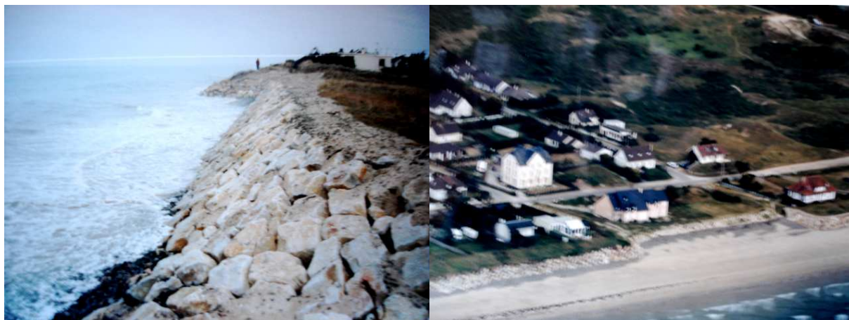
Figure 4-3 : vues des enrochements sur la parcelle AN-414-543.
