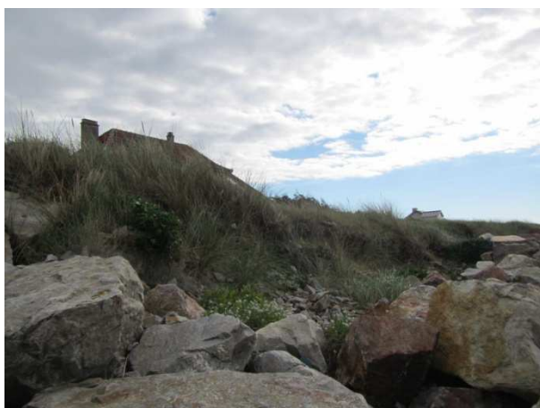
Petite anse d'érosion en arrière des enrochements – partie centrale
