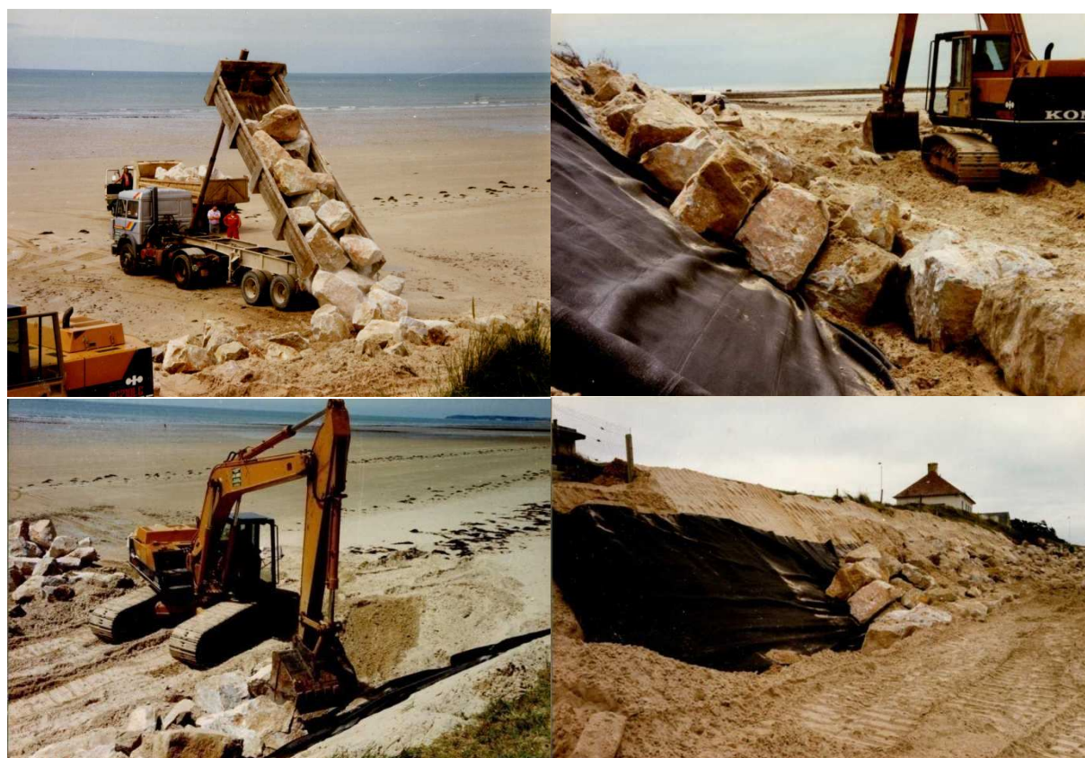
Figure 4-2 : mise en œuvre des enrochements sur les parcelles AB-436 et AB-437.
