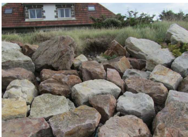
Petite anse d'érosion en arrière des enrochements – partie centrale
