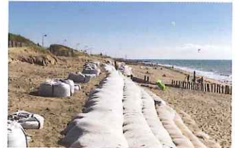
Big bags en géotextile à Gouville-sur-Mer (29/08/16 © photo Thierry Houyel)
