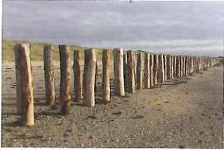
Pieux hydrauliques à Agon-Coutainville (11/10/17 © photo Pays de Coutances)
