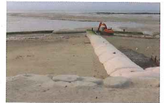
Epi géotextile en « T » à Gouville-sur-Mer (06/12/17 © photo Pays de Coutances)
